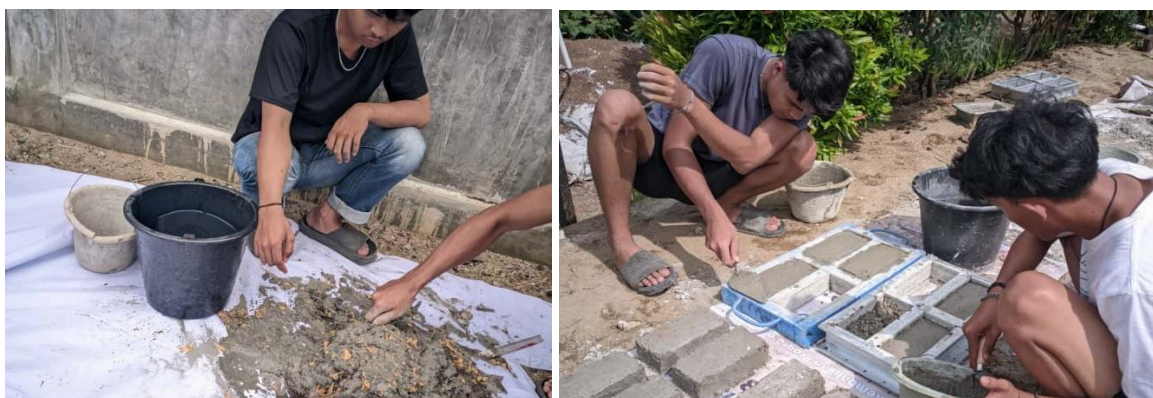
Gambar 2. Foto saat pencampuran plastik dengan semen dan pasir Foto saat pencetakan konblok.
